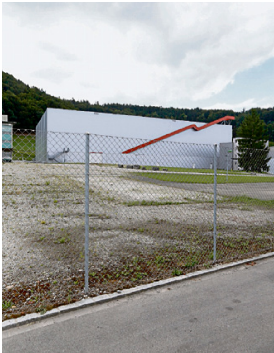
In den ehemaligen Produktionshallen der Thurella AG in Eglisau werden Rohre beschichtet und Kinder unterrichtet. Bald wird hier auch Yoga praktiziert. Bild: David Küenzi
